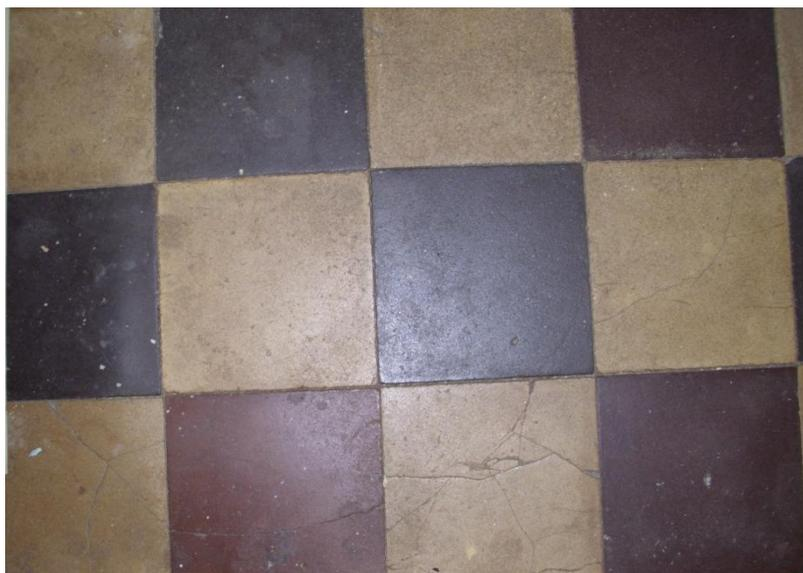
Figura 128 – Detalhe do piso em ladrilho hidráulico encontrado nos ambientes de serviço, foto em 2011.
