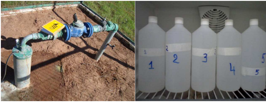
Figura 8: Poço onde foi coletada a amostra P1 (esquerda) e amostras refrigeradas (direita).
