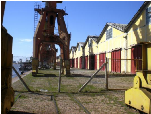
Foto 1 – “Edificações afastadas” do Cais Mauá Fonte: Otávio Vieira / 7 de julho de 2010
