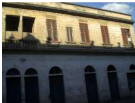
Foto 117 – Casarão na Rua Garibaldi Fonte - Otávio Vieira – 3 de dezembro de 2010
