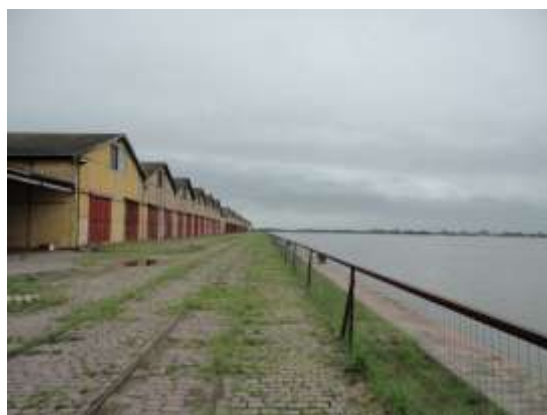
Foto 137: Possível local de instalação de pérgola no Cais Mauá Fonte: Otávio Vieira - 26 de março de 2011
