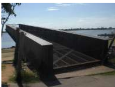
Foto 101: Obra da Ponte
