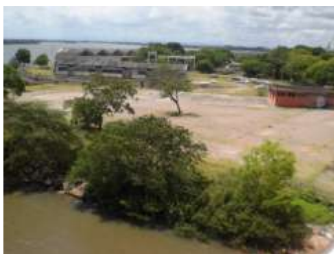
Foto 56: Setor 1 – Vista do Gasômetro Fonte - Otávio Vieira – 26 de novembro de 2010
