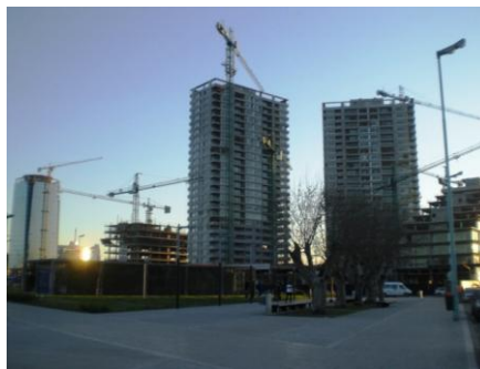
Foto 12: Dique 1, ainda em construção Fonte: Otávio Vieira – 5 de setembro de 2010
