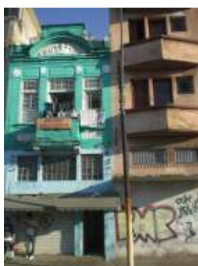
Foto 112 – Prédio da Avenida Farrapos Fonte: Otávio Vieira – 3 de dezembro de 2010
