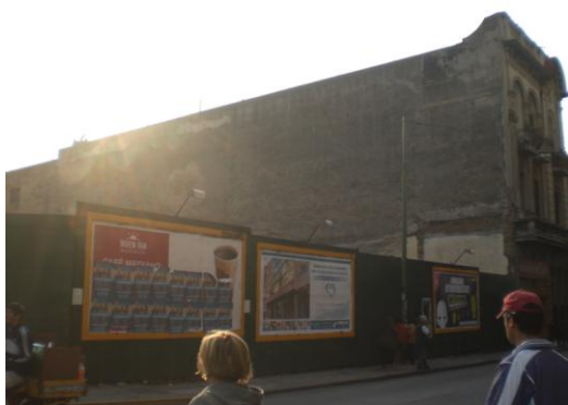
Foto 51: Edifício demolido da esquina Independência com Peru Fonte: Otávio Vieira – 19 de agosto de 2010
