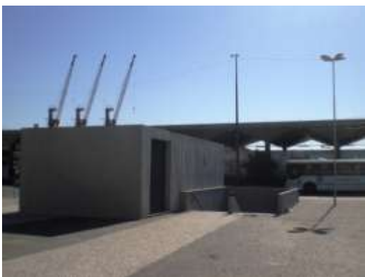
Foto 59 – Passagem subterrânea para o cais Fonte: Otávio Vieira – 7 de julho de 2010
