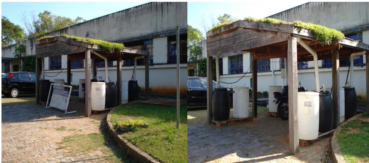
Figura 4.11: Cobertura verde instalada no IPH/UFRGS.
