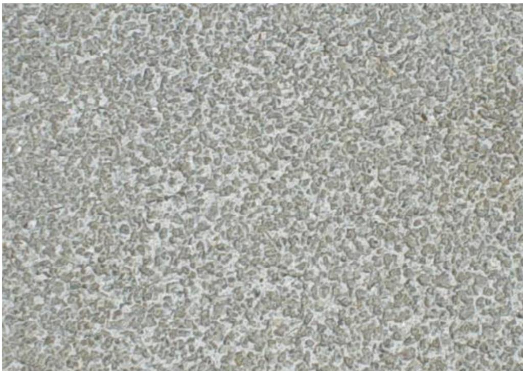
Figura 3.7: Pavimento permeável com sinais de colmatação superficial.
