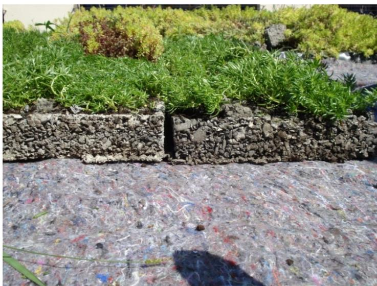
Figura 4.10: Instalação do telhado verde no Instituto de Pesquisas Hidráulicas/UFRGS.
