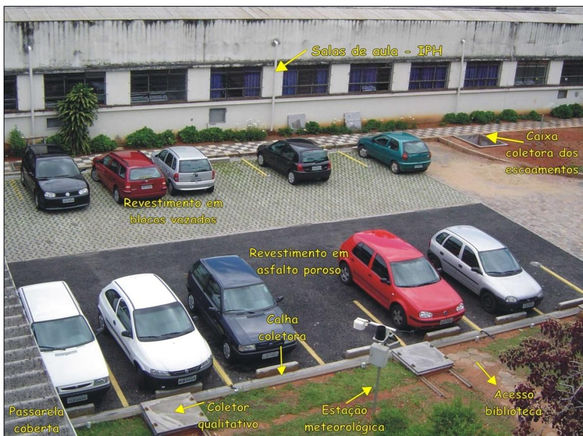
Figura 4.2: Pavimento permeável instalado no Instituto de Pesquisas Hidráulicas/UFRGS.
