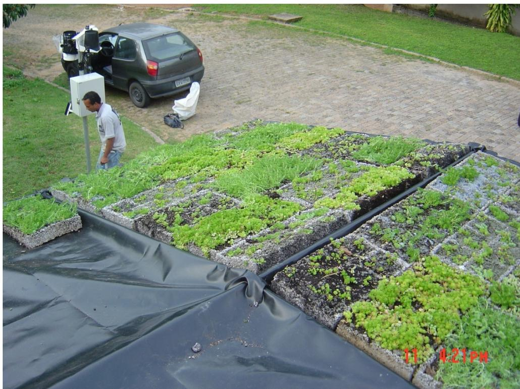
Figura 4.8: Cobertura verde instalada no IPH/UFRGS.
