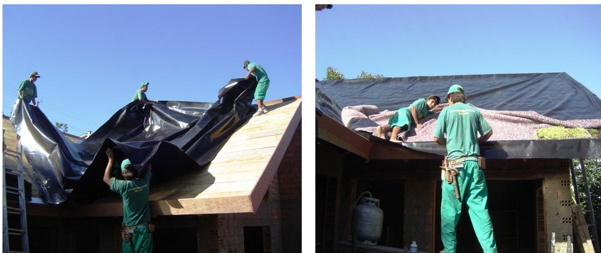
Figura 4.9: Colocação das membranas em um telhado verde.
