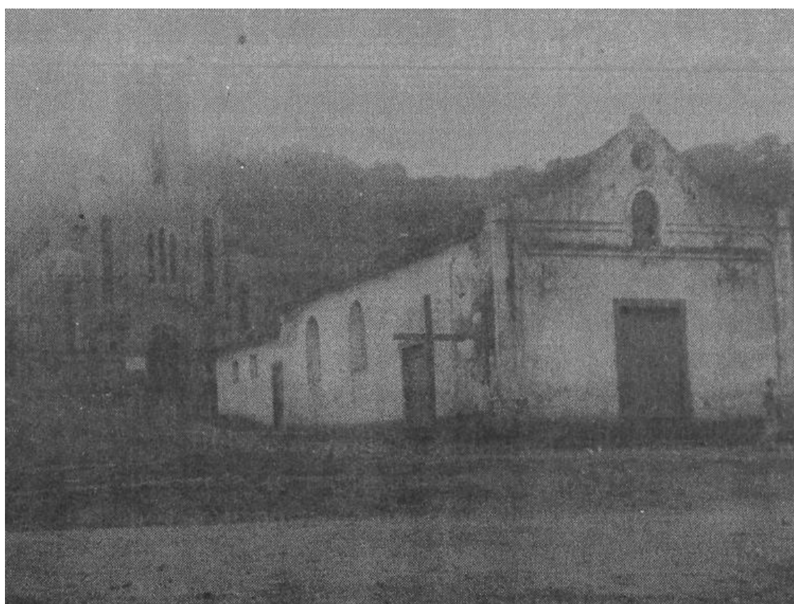
Figura 15 - Igreja Matriz da Colônia (primeiro plano), construída pelos imigrantes em 1853 e demolida em 1957
