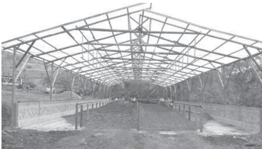
Foto 35 - A construção de unidade mecanizada e automatizada (UMAC) na propriedade dos irmãos Kummer – Itapiranga/SC
