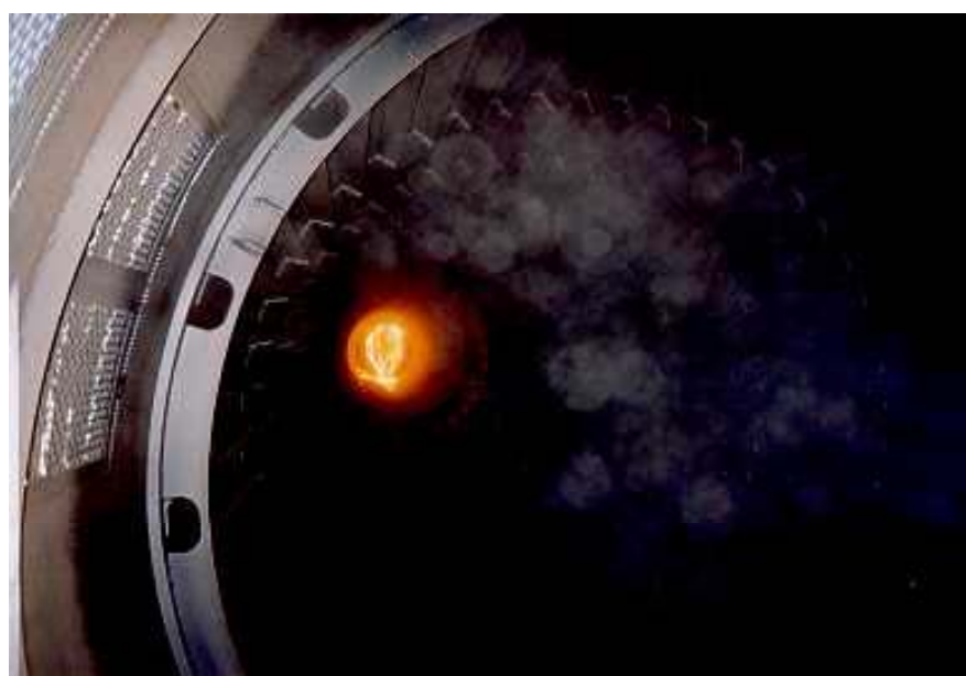
Figura 11. Interior do forno de magnésia cáustica. Magnesitas Navarras, S.A.
