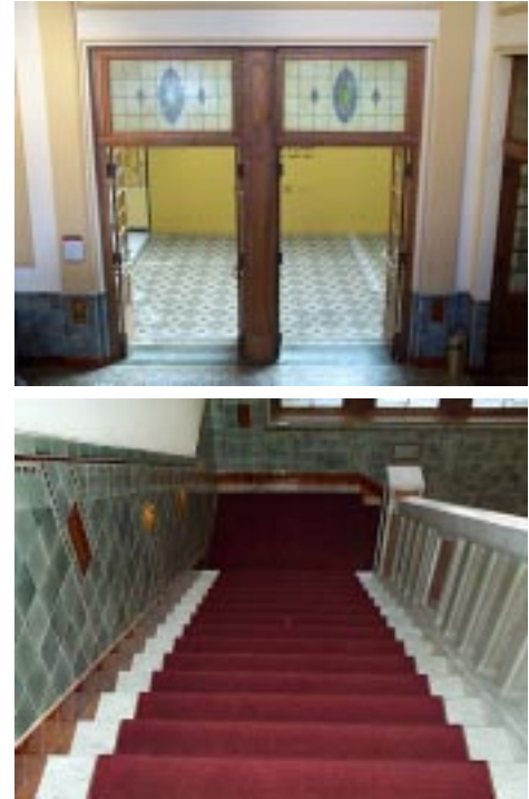
Figura 076: MARGS, Porta com bandeira em vitraux e escada em mármore e laterais em azulejos personalizados, 2003. Fonte: www.margs.terra.com.br Acessado em: 26 de março de 2003.
