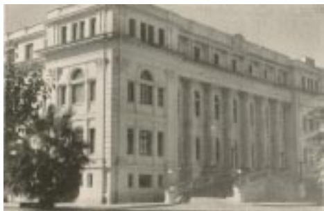
Figura 049: Edifício da Secretaria da Fazenda, Porto Alegre, 1930. Fonte: Porto Alegre –um século em fotografia. CD-ROM.
