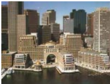
Figura 008: Complexo de Rowes Wharf, Boston. Fonte: www.vitruvius.com.br. Acessado em: 04 março de 2003.
