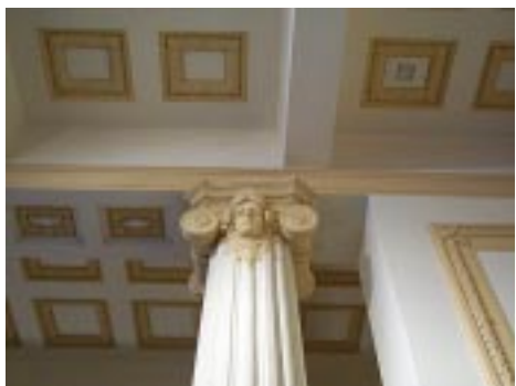
Figura 075: MARGS, Vitral restaurado que cobre o átrio, detalhe piso de ladrilho hidráulico restaurado e ornamentos na coluna e teto, 2003. Fonte: www.margs.terra.com.br Acessado em: 26 de março de 2003
