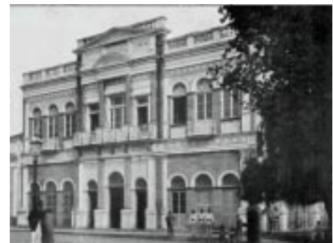
Figura 044: Edifício do Tesouro Federal, situado na rua Sete de Setembro. Em seu lugar hoje está o Banco do Estado do Rio Grande do Sul, BANRISUL. Fotografia de 1898.
