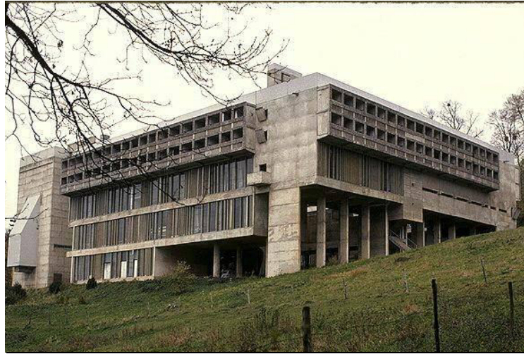
Figura 12 - Convento de La Tourette (1950/55); Le Corbusier.
