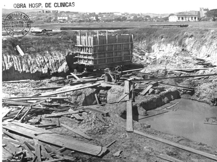
Figura 94: carga de prova das estacas do Hospital de Clínicas – nov.
