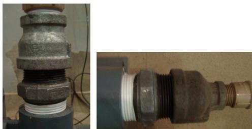
Figura 29: Peças de ferro fundido acopladas ao bocal de entrada e saída da bomba helicoidal
