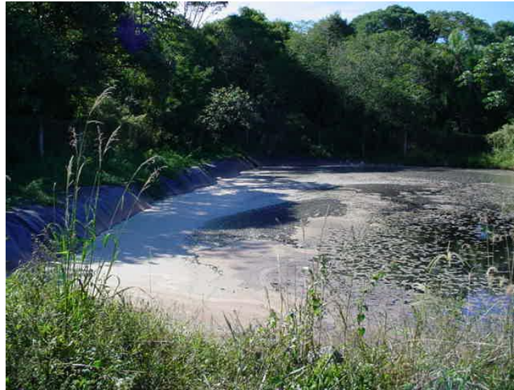
Figura 4. Tanque de tratamento anaeróbio de chorume.
