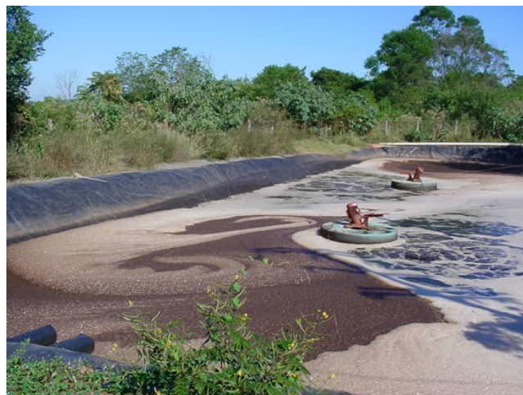
Figura 5. Tanque de tratamento aeróbio de chorume.
