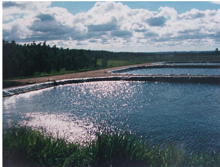
Figura 10 : Lagoas de estabilização para tratamento de chorume- 2003. Autor: Vitor Hugo Konarzewski
