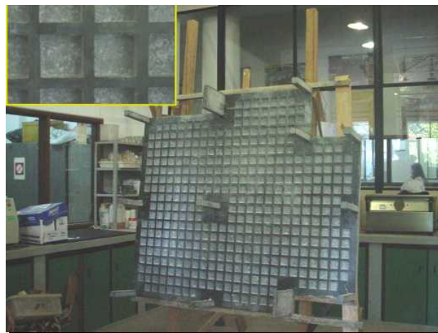
Figura 4.35 – Vista da parte inferior da laje após a retirada das fôrmas
