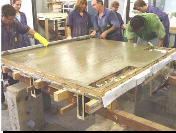
Figura 4.29 – Regularização da superfície da laje
