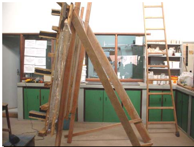
Figura 4.32 - Estrutura de apoio da laje para descimbramento
