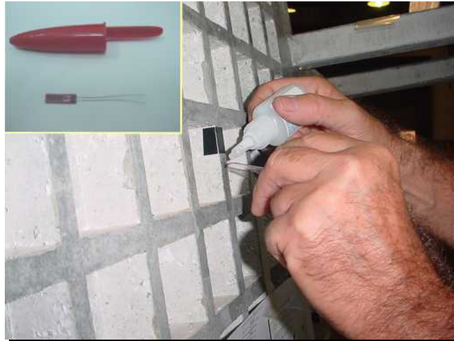
Figura 4.37 – Colagem dos extensômetros
