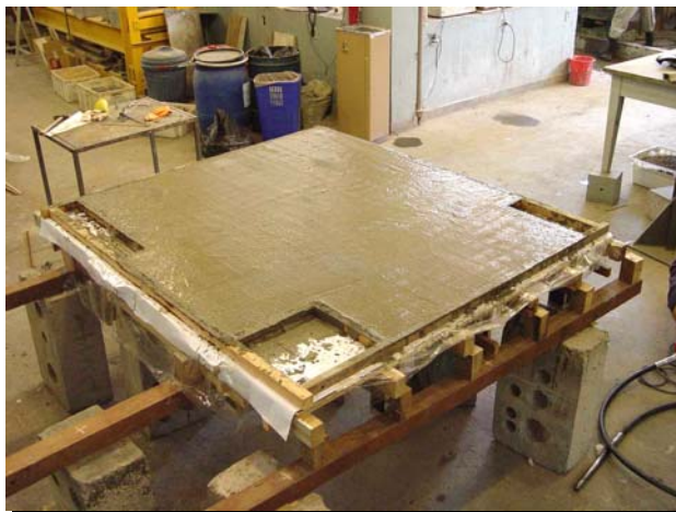
Figura 4.30 – Final da concretagem
