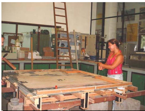
Figura 4.4 – Estrutura da fôrma do modelo reduzido
