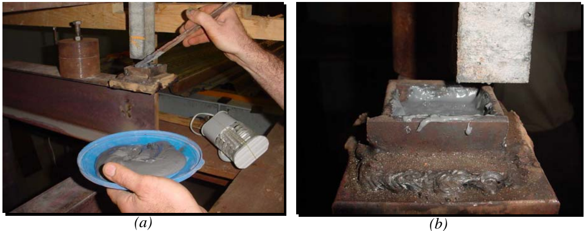
Figura 4.45 - (a) e (b) Colocação do epóxi para fixação dos pilares
