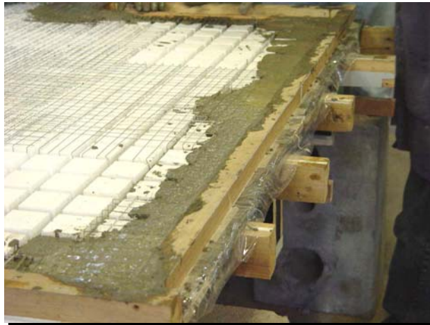
Figura 4.27 – Lançamento do microconcreto na fôrma
