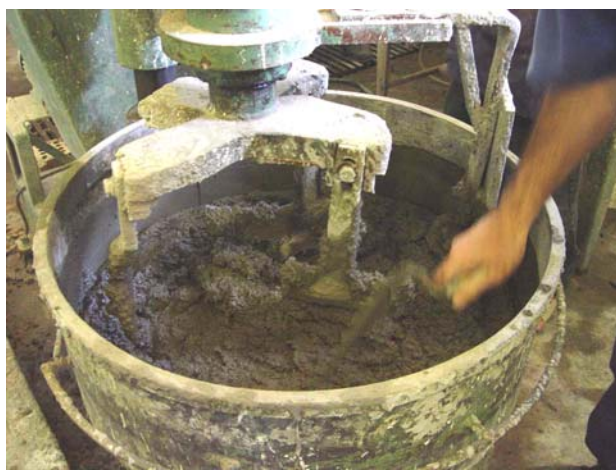
Figura 4.26 – Aspecto da mistura do microconcreto
