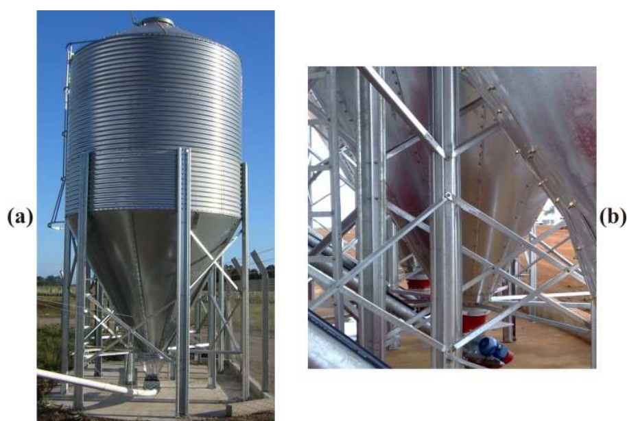
Figura 6.1. Estrutura real analisada. (a) Silo de armazenagem e colunas de sustentação. (b) Detalhe dos apoios intermediários das colunas.
