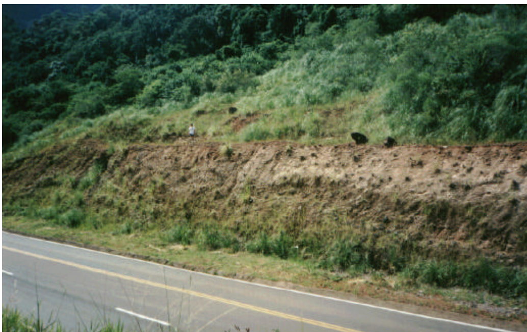
Figura 3.1: Vista geral do talude Teutônia (Rigo, 2000)
