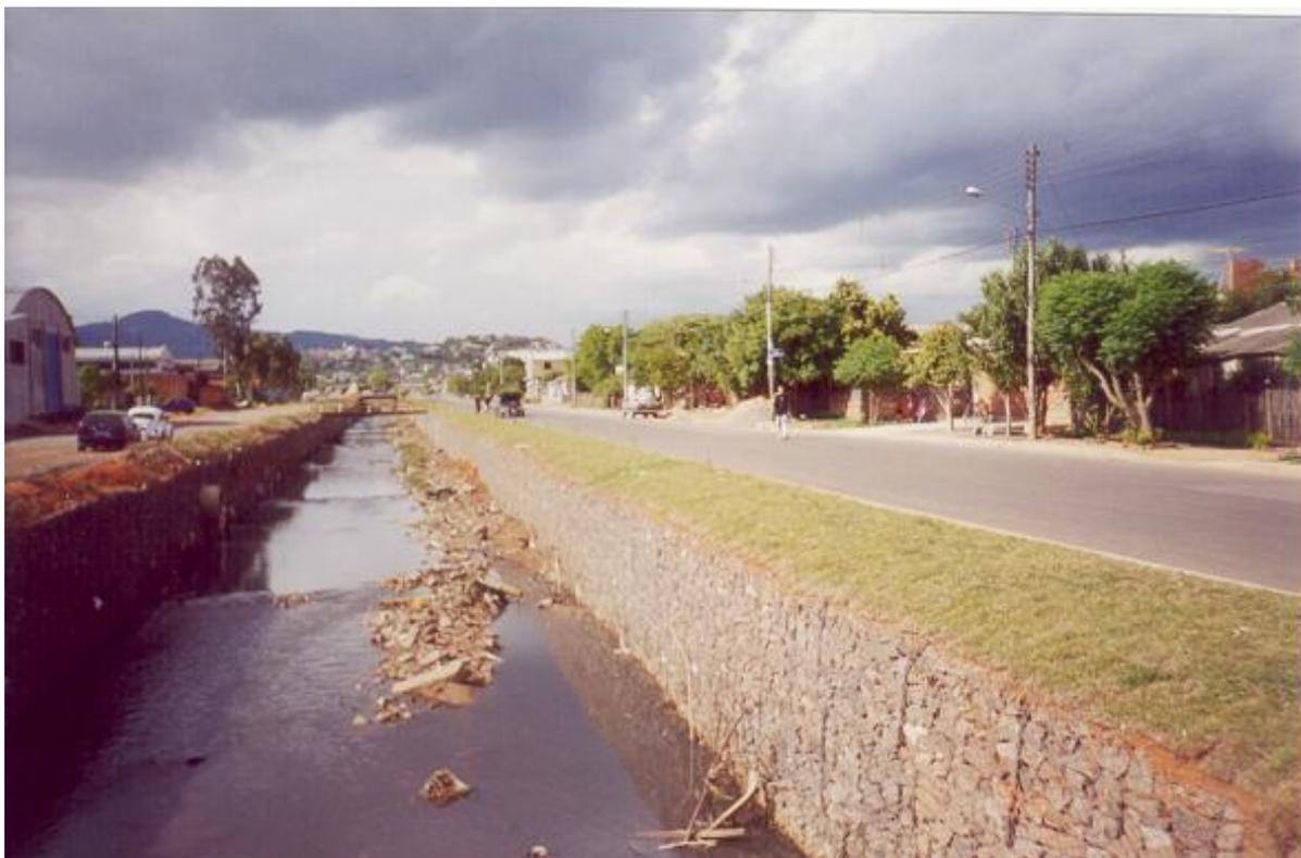
**Figura 9** - Parte da avenida Alcântara, em uma das margens do arroio Pampa. Quando estiver concluída, margeará todo o arroio Pampa, canalizado com os gabiões (muros de contenções).
