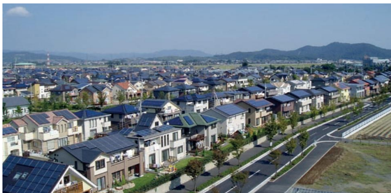
Figura 10 - Conjunto de residências com geração de energia.
