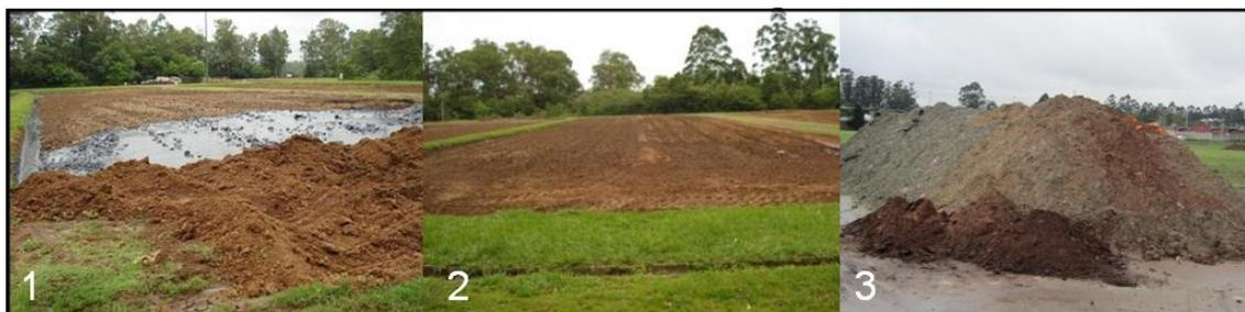
FIGURA 7: Células de *landfarming* do SICECORS (1) após recente aplicação de borra oleosa; (2) após duas semanas de realização do revolvimento do solo (Fonte: Cerqueira, 2011). (3) Biopilha da empresa Ipiranga (Fonte: Mariana W. Duarte, 2011).
