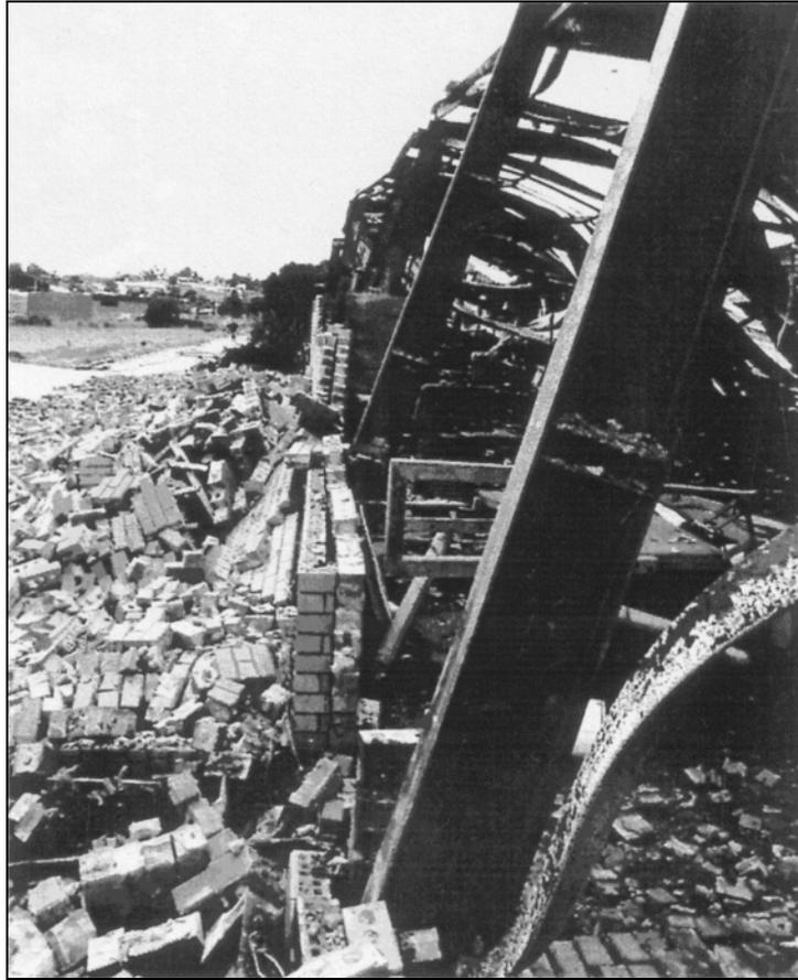
**Figura 3.8 – Colapso da parede de alvenaria, provocado pela expansão térmica do pórtico (O’MEAGHER *et al.*, 1990).**
