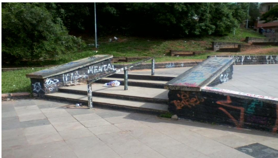
FIGURA 6 – ESCADA E CORRIMÃO. Acervo do próprio pesquisador.
