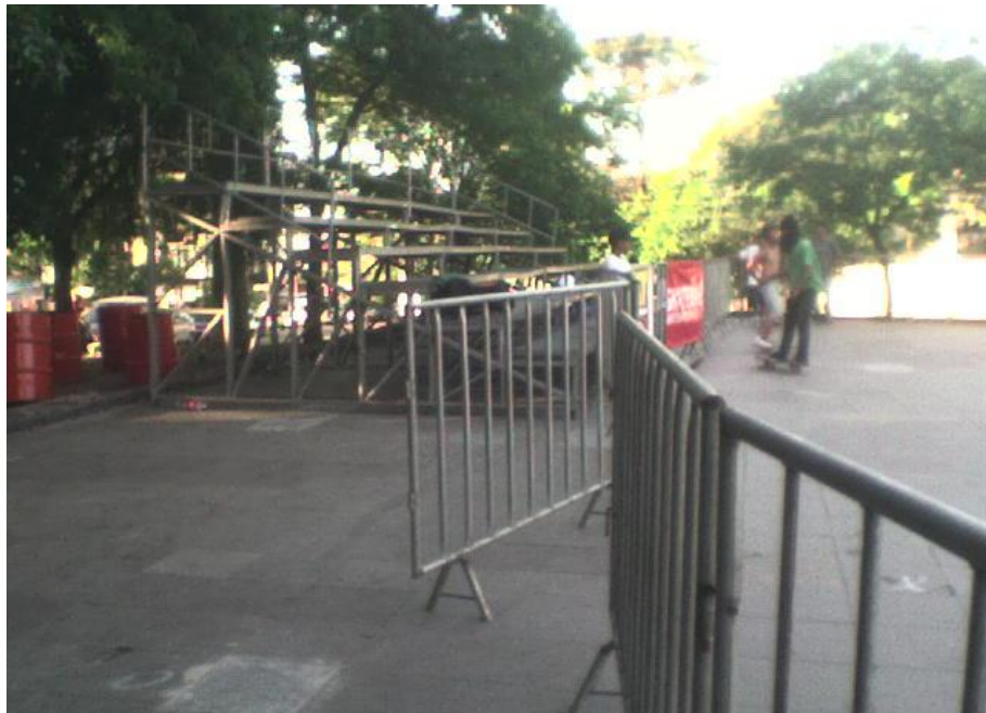
FIGURA 10 – MONTAGEM DA ARQUIBANCADA NA “ENTRADA DA PISTA” (isolamento da área de competição, que ocorreu no dia seguinte). Acervo do próprio pesquisador.
