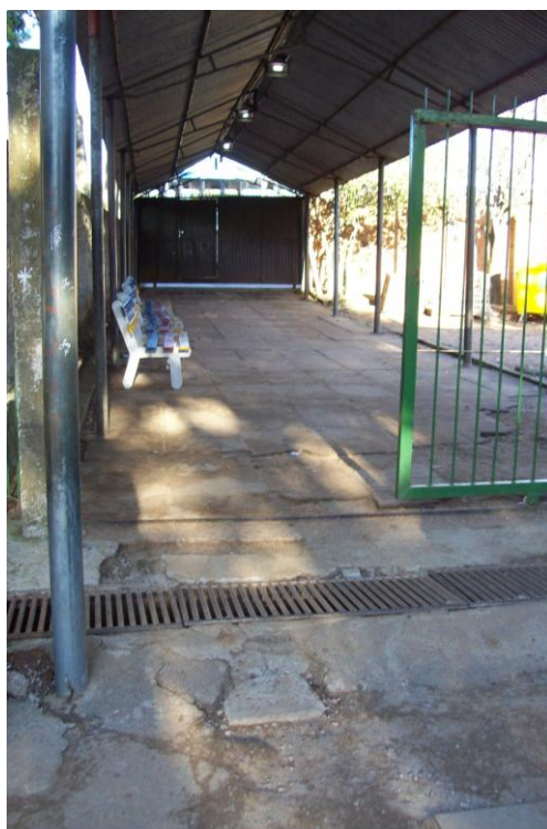
Figura 40 – Vista interna do acesso de entrada da aluna cadeirante
