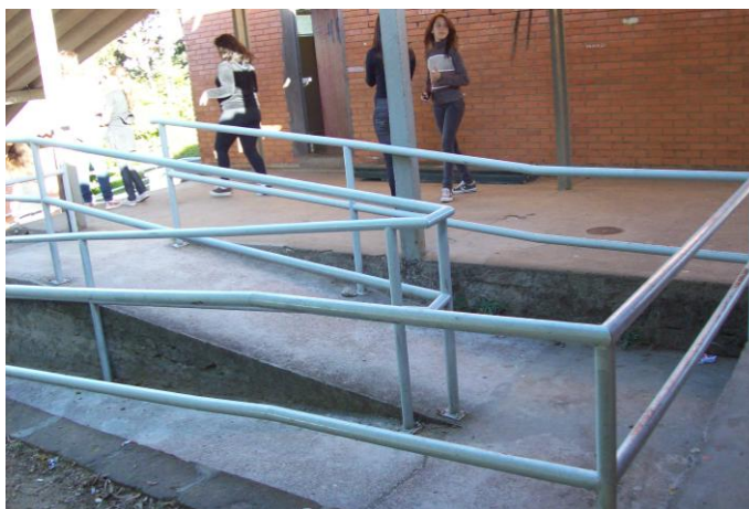
Figura 46 – Rampa no interior da escola
