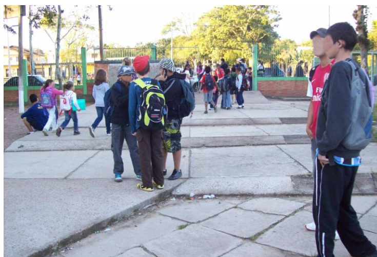
Figura 50 – Desníveis da entrada principal da escola
