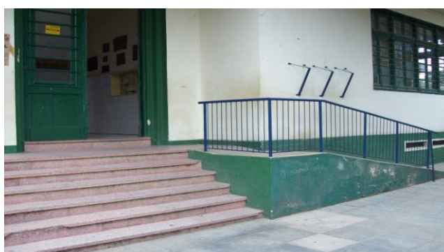
Figura 21 – Rampa da entrada principal
