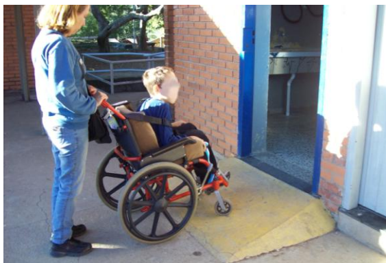
Figura 47 – Entrada do banheiro
