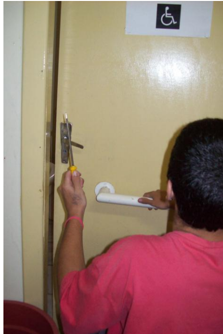
Figura 34 – Chave de abertura da porta do banheiro acessível
