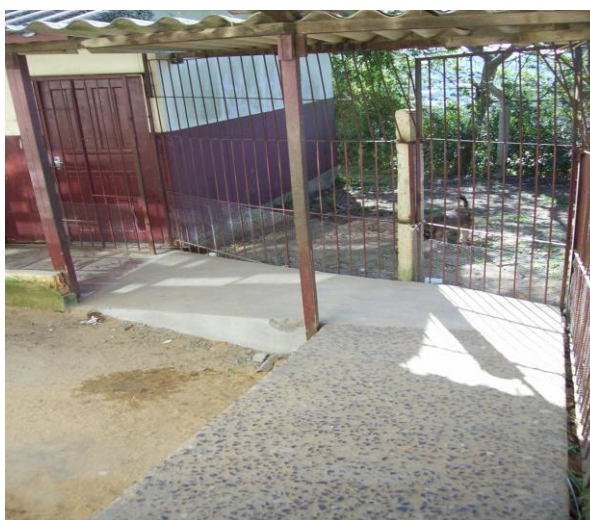
Figura 19 – Rampa que leva ao refeitório
