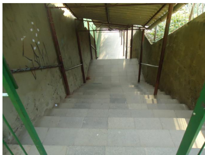
Figura 39 – Corredor de acesso entre pavilhões
