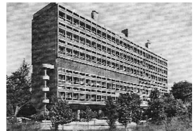
1.3.12 Unité d'Habitation de Marselha , Le Corbusier, 1953. Modelo de referência para os regulamentos que propiciam o edifício «torre» em Buenos Aires
