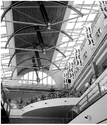
3.3.4.12 Juan Carlos López e Assoc., Pátio Olmos, Córdoba, 1995, telhados com a estrutura tratada de forma ornamental
