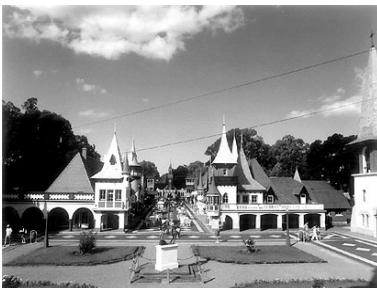
3.4.4.15, 3.4.4.16 e 3.4.4.17 "República de los niños", Gonnet, Província de Buenos Aires, construída por Perón entre 1949 e 1951 (arquitetos Lima-Cuenca e Gallo)
