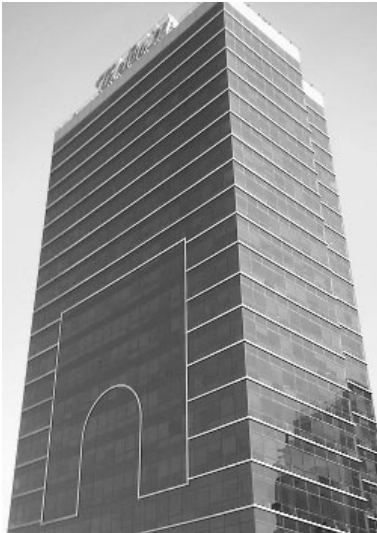
3.2.4.14 Edifício de Telefônica na Avenida Huergo, Buenos Aires, 2003. Os perfis decorativos exteriores são aplicados sobre a superfície de vidro conservando uma independência estrutural e formal entre ambos os sistemas
