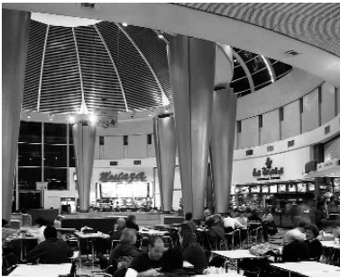
3.3.4.13 Pfeifer e Zurdo, Renovação Alto Palermo, Buenos Aires, 2001. As formas das colunas coniformes de chapa e a abóbada decorativa são independentes da estrutura sustentadora
