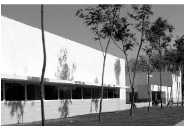
2.6.6 e 2.6.7 Álvaro Siza, Centro Municipal Distrito Sul, Rosário, Argentina, 1998-2001 Janela de ponta a ponta do exterior e do interior, mostrando as divisões das peças
