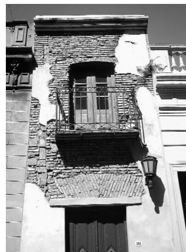
4.11.15 San Lorenzo 380, San Telmo, Buenos Aires, restauração da chamada "casa mínima" deixando os tijolos aparecerem e recortando cuidadosamente o reboco "não caído"
