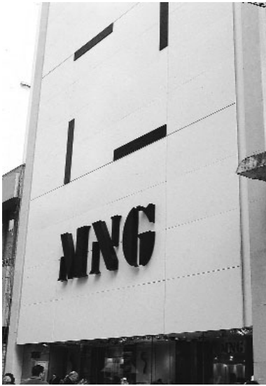
3.4.1.9 Loja MNG na rua Florida, Buenos Aires, 1999. A fachada-cartaz oculta o edifício remodelado
