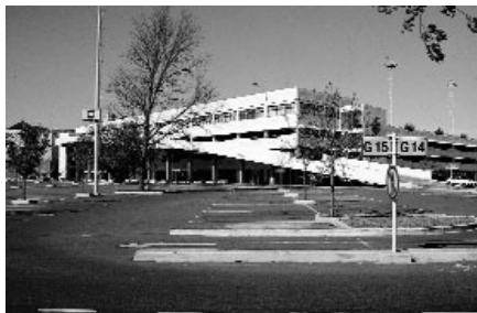
3.3.4.22 e 3.3.4.23 Vista da chegada ao centro comercial Unicenter, Martínez, Buenos Aires, com o edifício de estacionamento entre a zona descoberta e o próprio centro comercial
