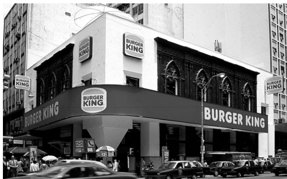
3.4.1.10 Loja de "Casa Mayorga", antes residência Elortondo-Alvear, que embora em 1936 tivesse sido modernizada em seu andar térreo, conservava sua arquitetura neogótica e salões do primeiro andar; foi remodelado para alojar Burger-King por Lacroze, Miguens, Iglesias, Prati em 1994
