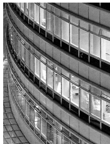
4.7.2 Edifício República por César Pelli & Ass.(33.000m 2 , 1996). Os perfis tubiformes horizontais, claramente separados do plano de fachada, cumprem uma função ornamental ao enfatizarem a curva do edifício
