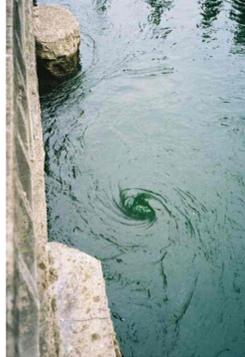
Vórtice em uma tomada d' água
