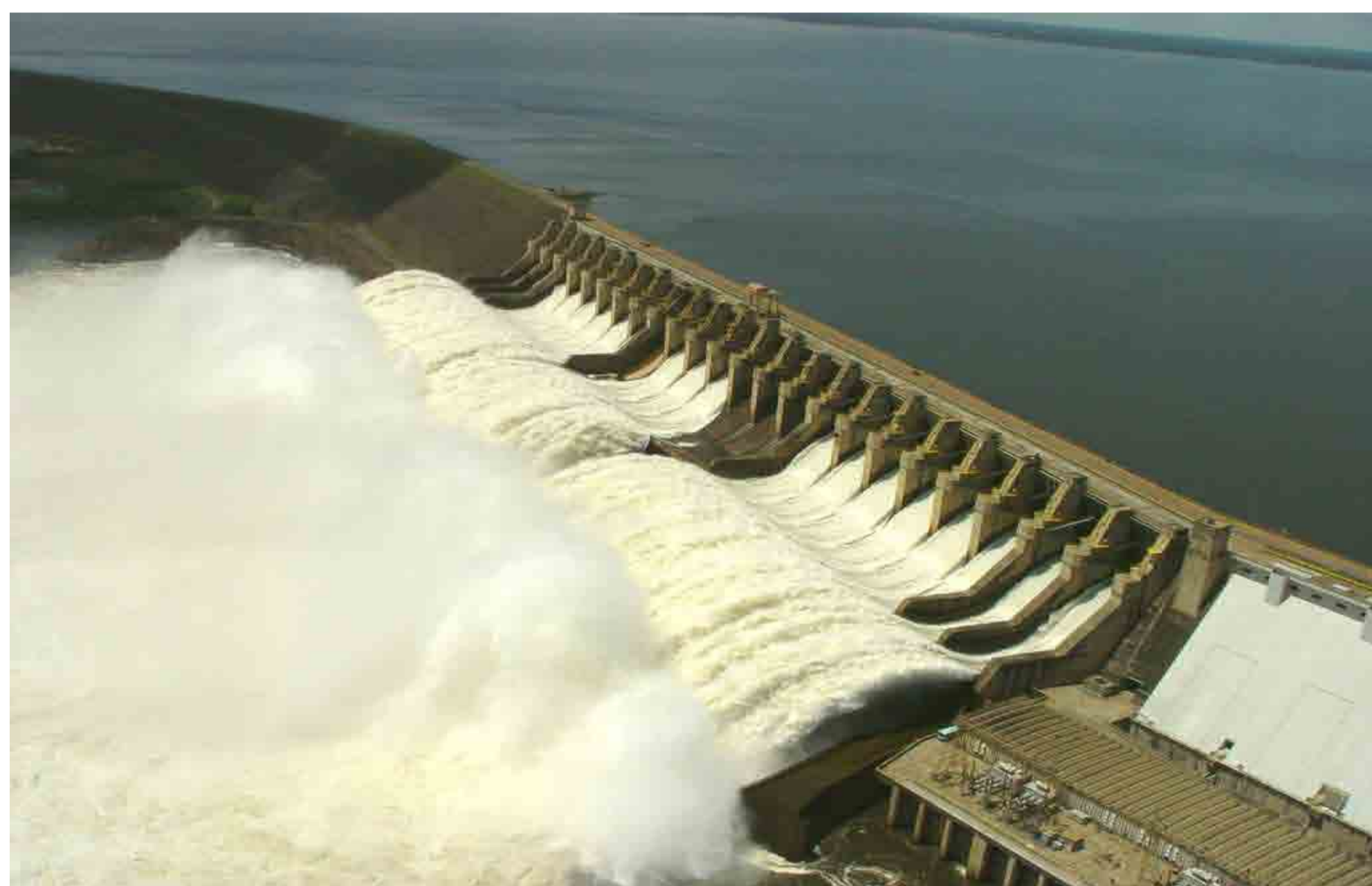
Vertedouro com salto de esquí – UHE Tucuruí, Brasil
