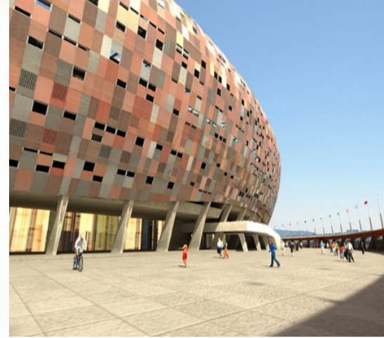
Figura 1: Estádio Soccer City, revestido com blocos de concreto pigmentado.
