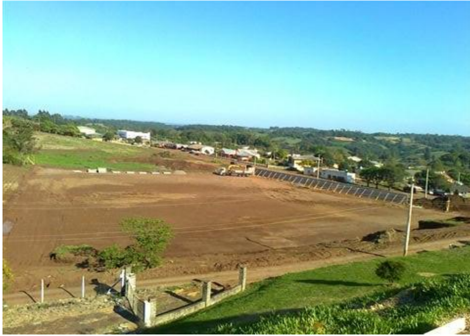
Figura 11. Terreno após a Terraplenagem.
