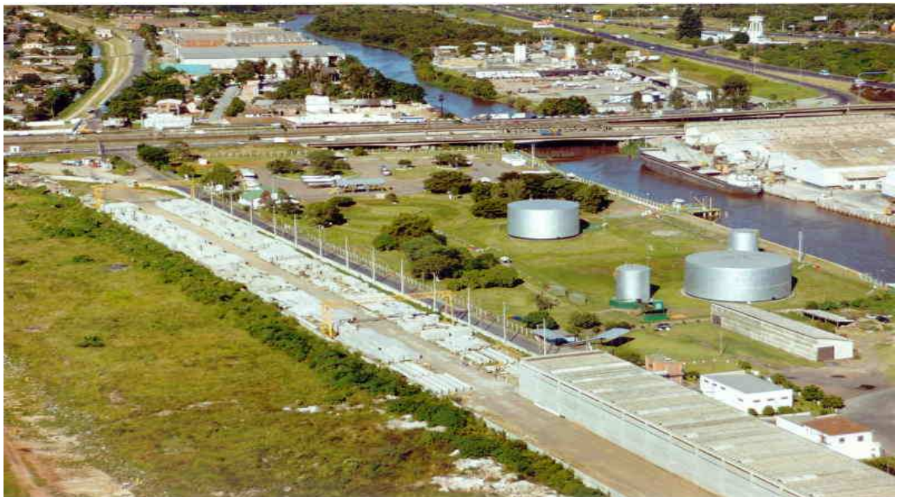
Figura 27 – Foto aérea do Terminal de Niterói – Tenit – em Canoas
