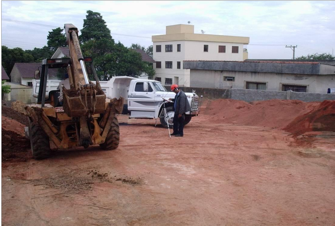
Figura 28– Repavimentação (Retro + caminhão caçamba).
