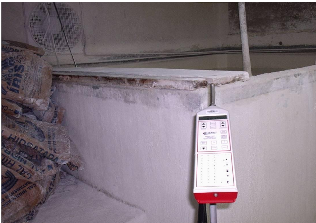
Figura 17- Exaustor da Tina do Cal Hidratado.
