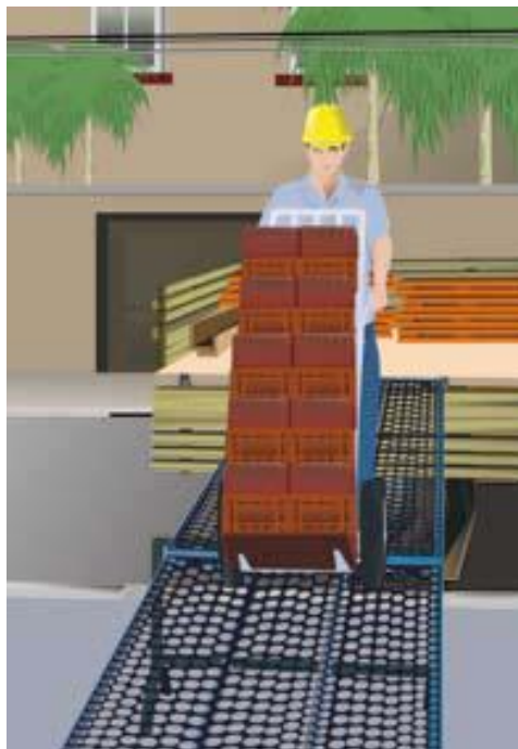
Figura 4: Rampa portátil e carrinho para descarga de material
