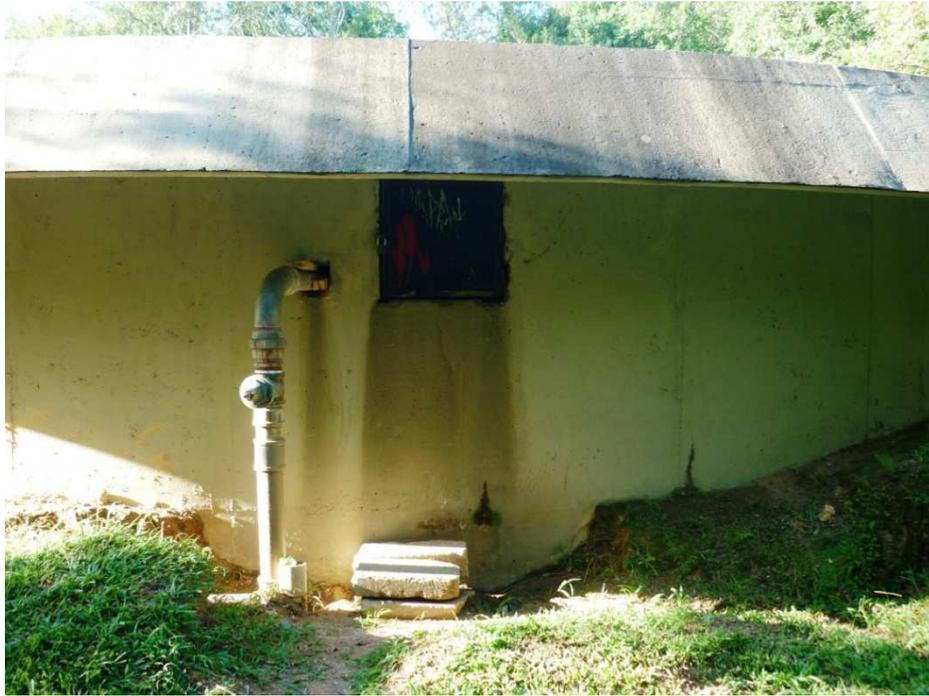
Figura 6 – Acesso de inspeção com portinhola em chapa metálica medindo 60x60cm.
