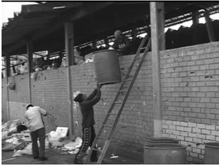
Foto 8.1.3 - Trabalhadores realizando a remoção dos resíduos espalhados no chão
