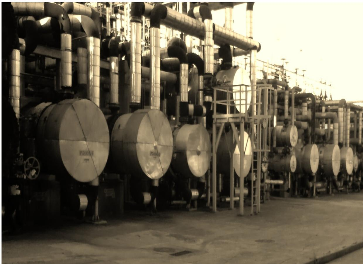
**Figura 4: Bateria de pré-aquecimento de petróleo**
