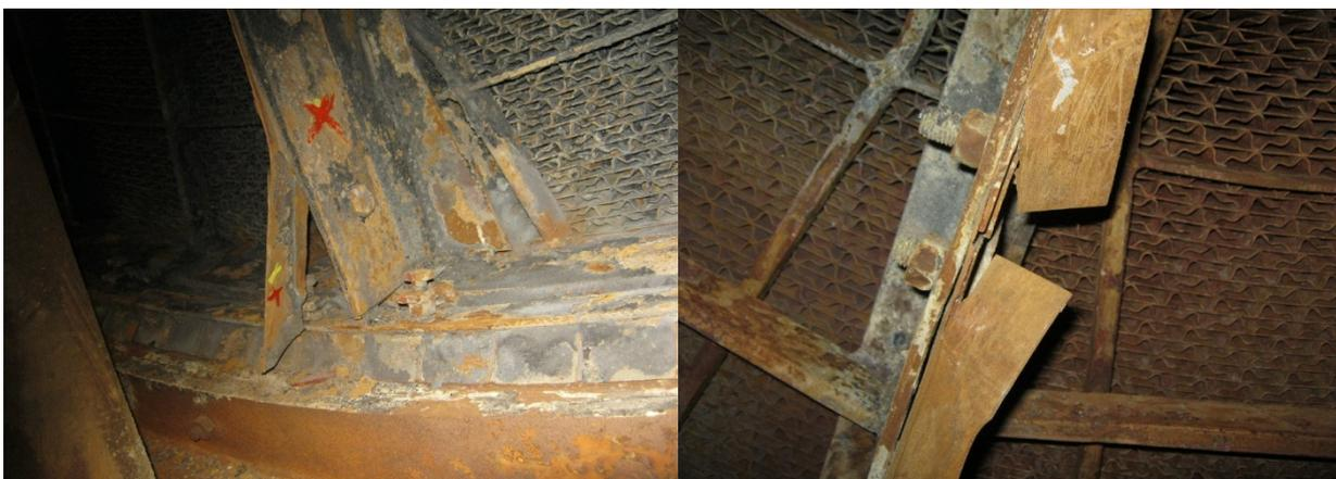
**Figura 10: Danos causados pela fadiga nas selagens radiais.**
