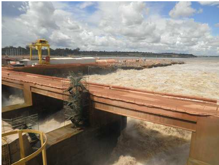
Figura 2.1: Ressalto hidráulico na bacia de dissipação do vertedouro da UHE Santo Antonio: vazão em 10 vãos de aproximadamente 35.000m³/s.
