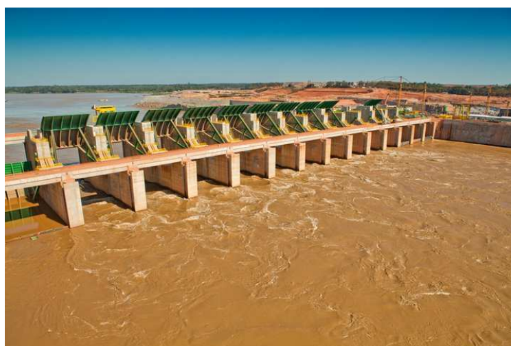
Figura 1.1: Vertedouro principal da UHE Santo Antonio: restituição da vazão ao leito natural do Rio Madeira, visto de jusante para montante, vazão 8450\text{m}^3/\text{s} ( Fr_1:1,34 ).
