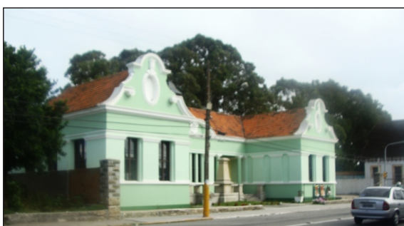
Figura 6. Prédio da escola.
