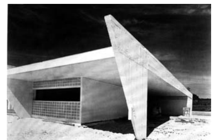
Fig. 423: Ginásio de Itanhaém, 1959, Vilanova Artigas.
