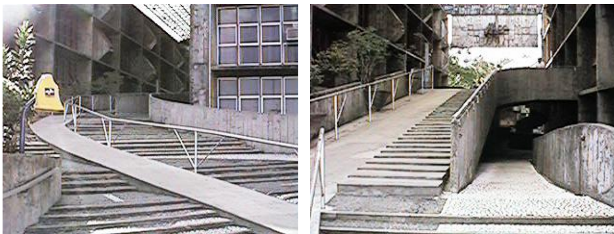
Fig. 624 e 625: detalhes das rampas curvas de acesso que conduzem o usuário ao terceiro andar do edifício de cinco andares.
