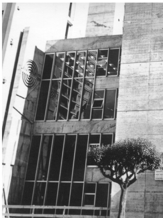
Fig. 709: fachada da agência.
