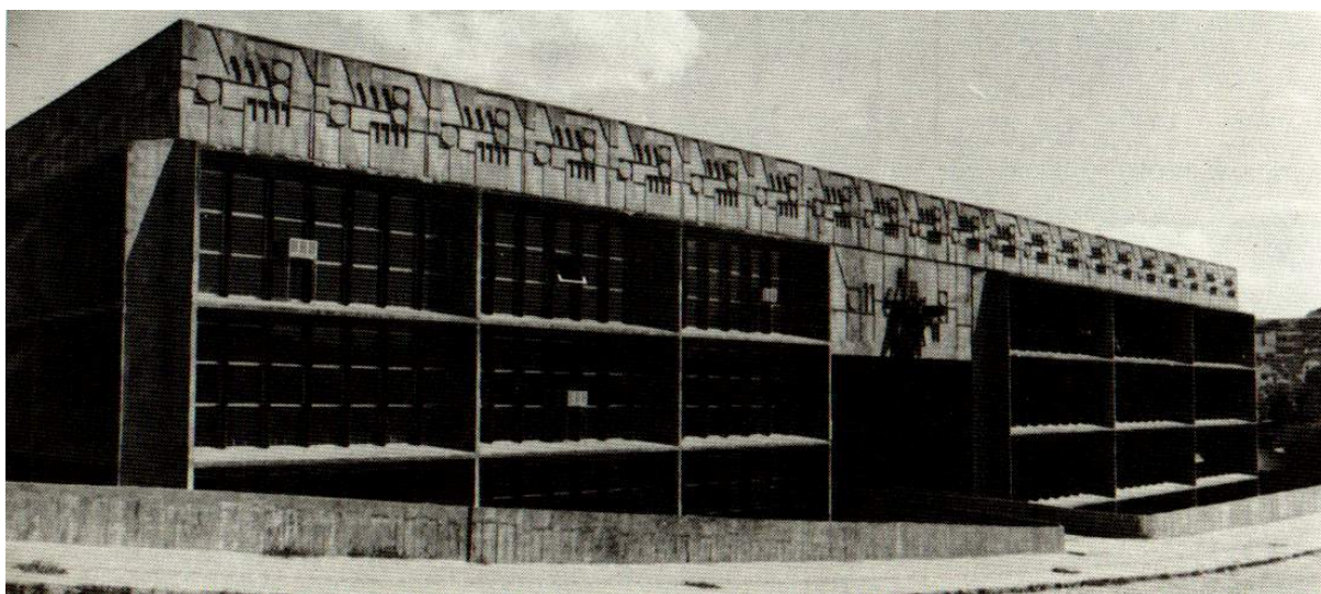
Fig. 616: vista externa da fachada posterior, voltada para a Travessa Raul Munhoz.
