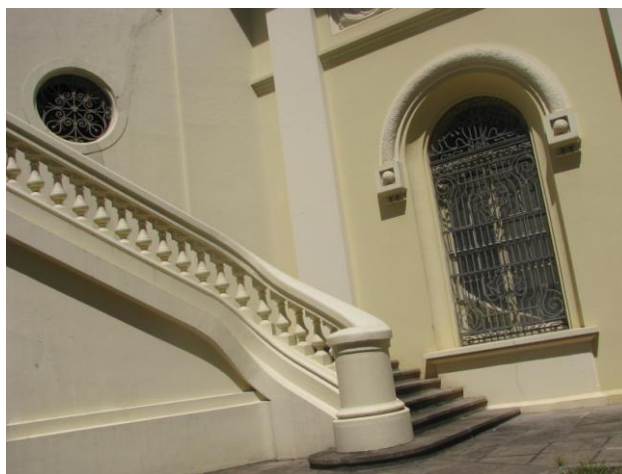
Fotografia 4 – Detalhe da escadaria do prédio
