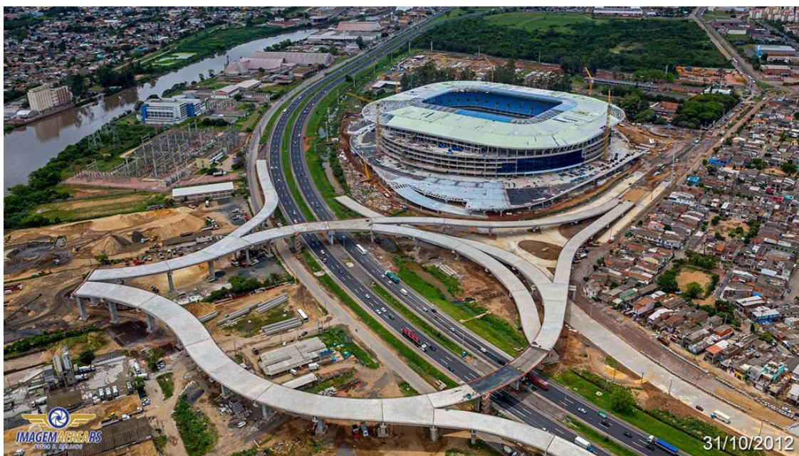
Figura 10: Arena Grêmio. Fonte: Imagem Aérea RS, 2012.
