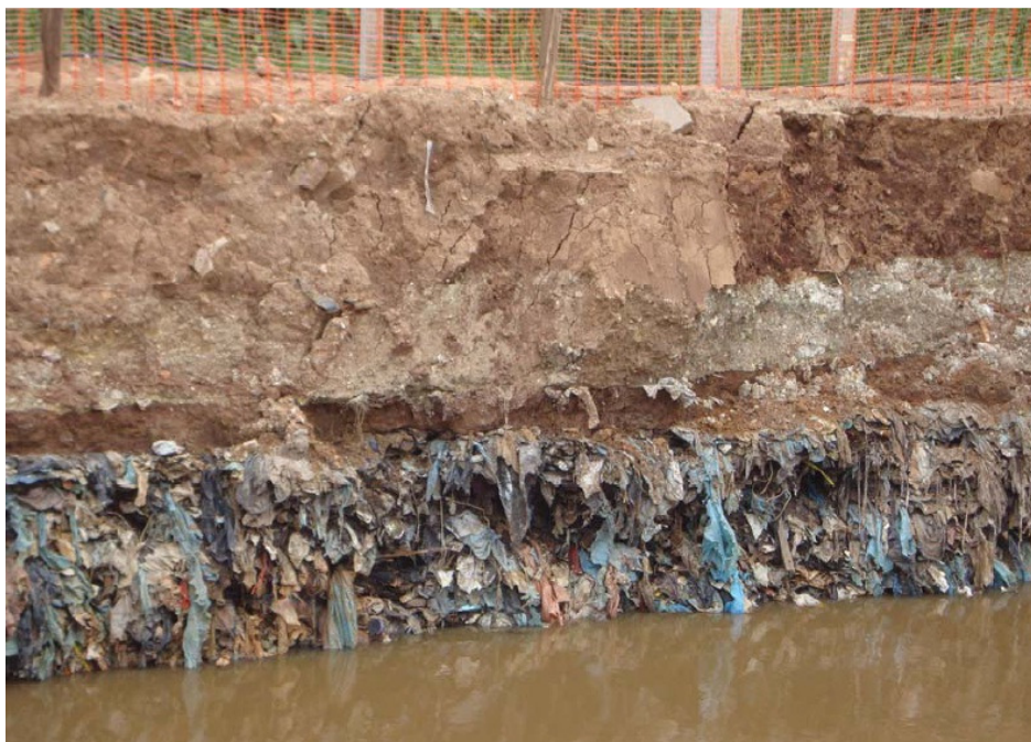
Figura 20: Camada de lixo compactado. Fonte: autor não identificado.
