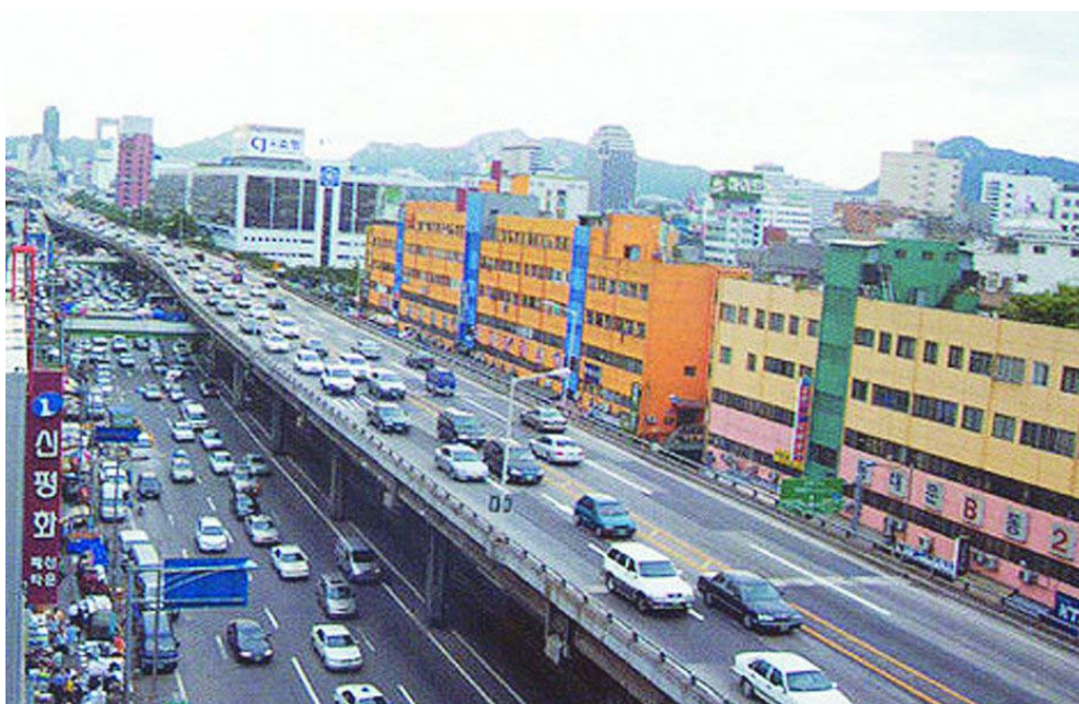
Figura 4: Via expressa por sobre o rio Cheonggyecheon (Coréia do Sul).
