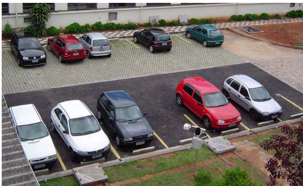
Figura 27: Estudos com Pavimento Permeável em Porto Alegre.
