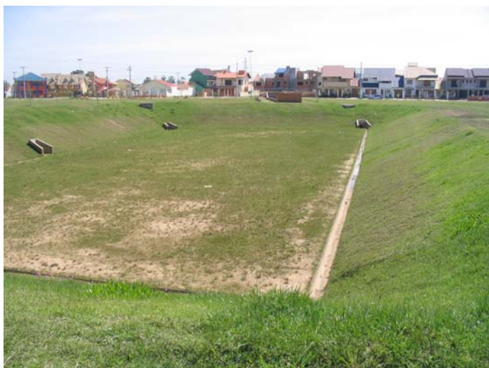
Figura 30. Reservatório de detenção em loteamento em Porto Alegre.
