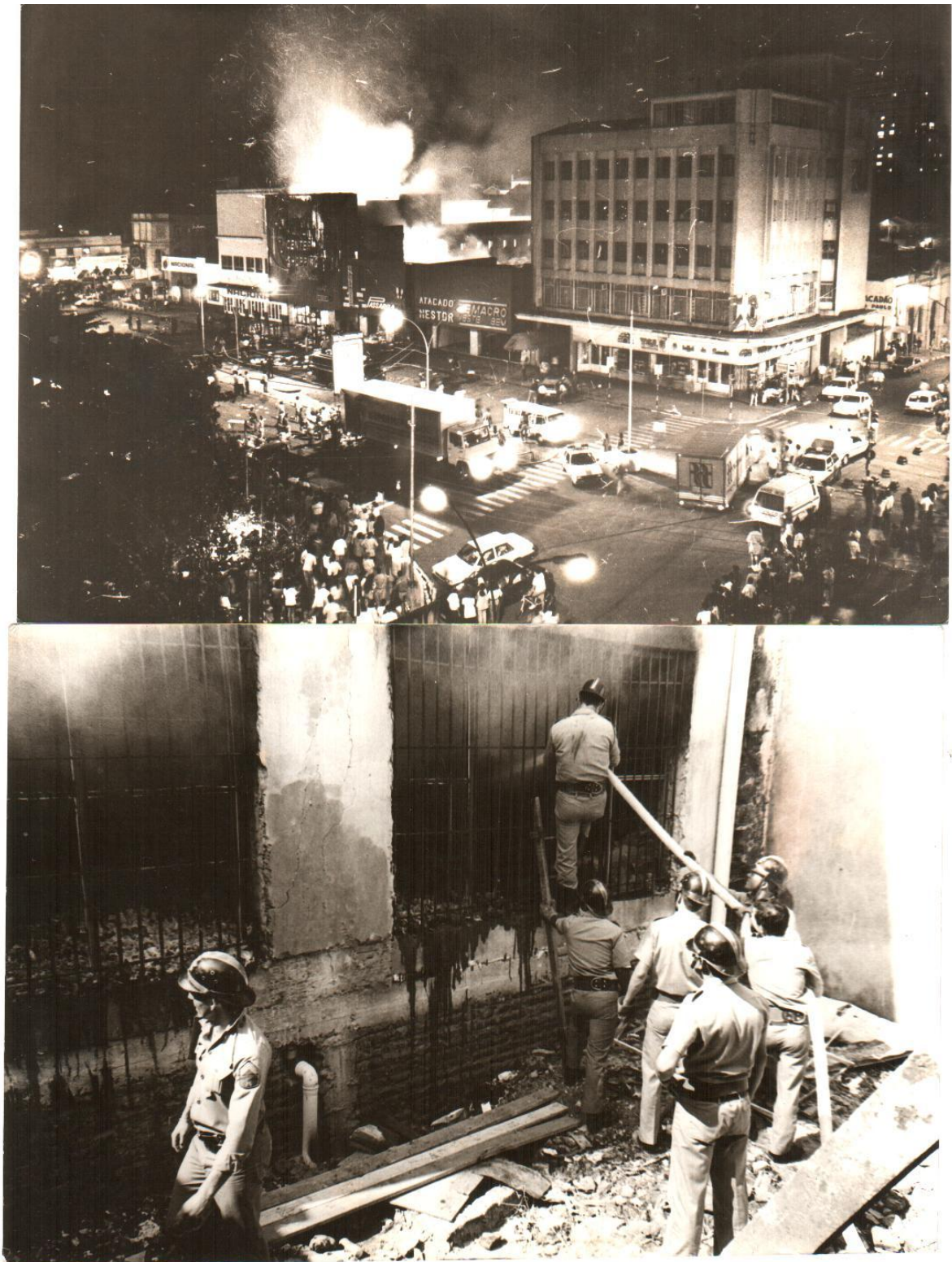
Figura 2 - Incêndio no Centro de Livramento (1995)
