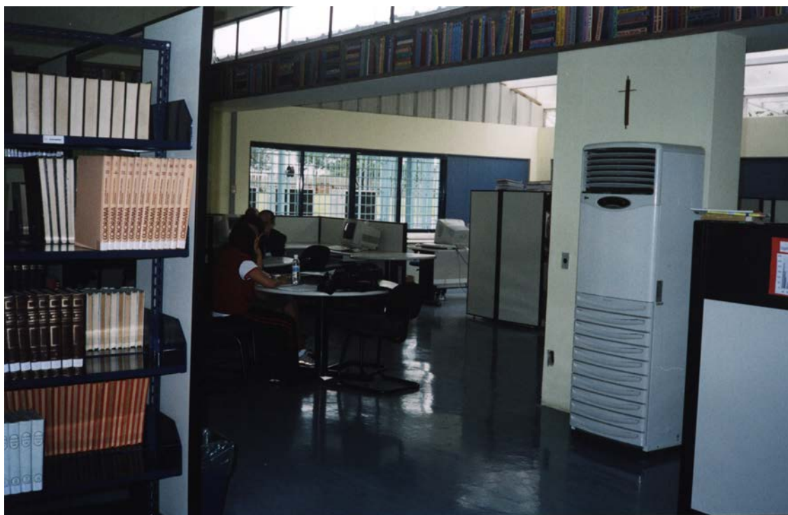
Figura 75 - à direita um dos aparelhos de condicionadores de ar, e à esquerda a disposição dos exemplares nas estantes
