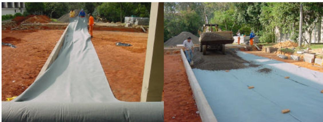
**Figura 3.14** – Posicionamento da manta geotêxtil sobre o subleito
