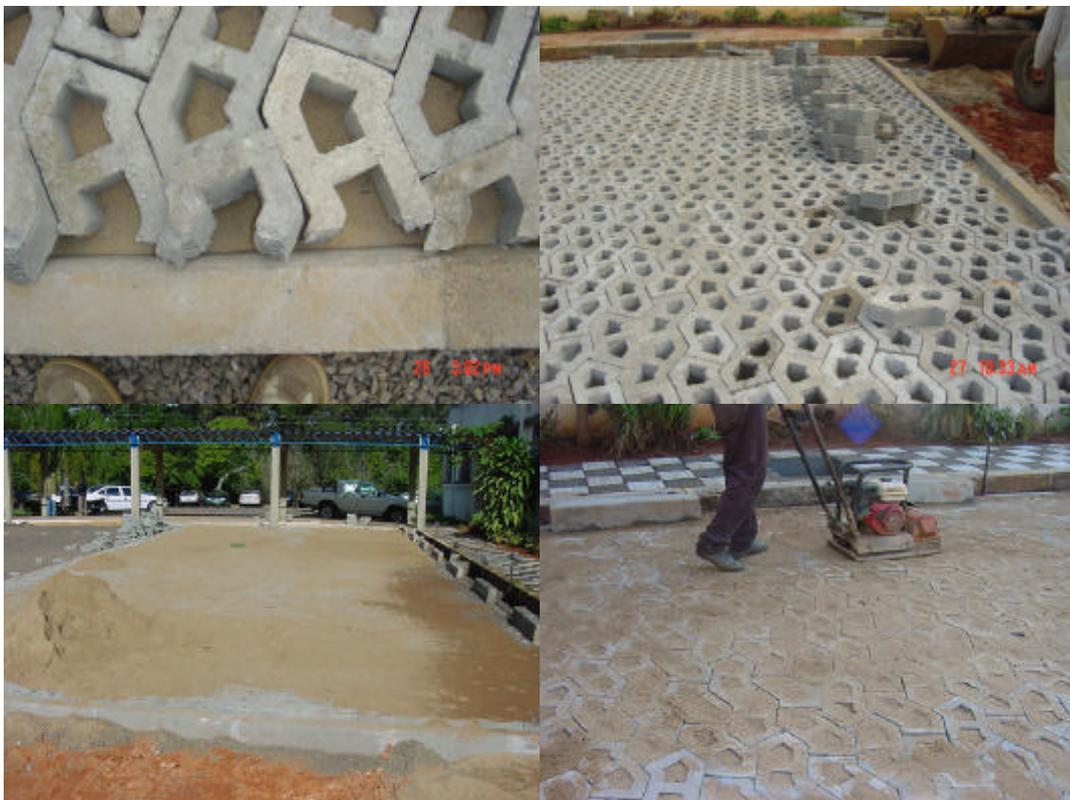
**Figura 3.16** – Execução do revestimento em blocos intertravados vazados
