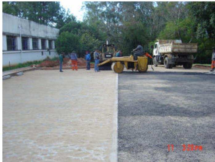
**Figura 3.18** – Estacionamento experimental permeável pronto
