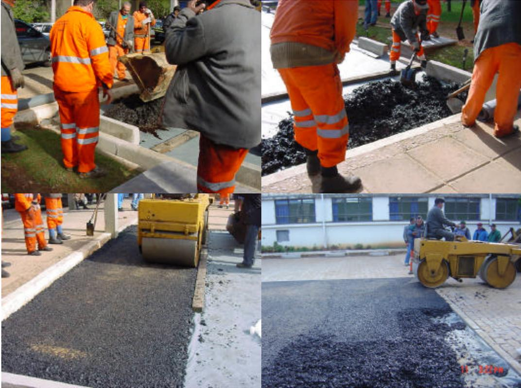
**Figura 3.17** – Execução do revestimento em PMF
