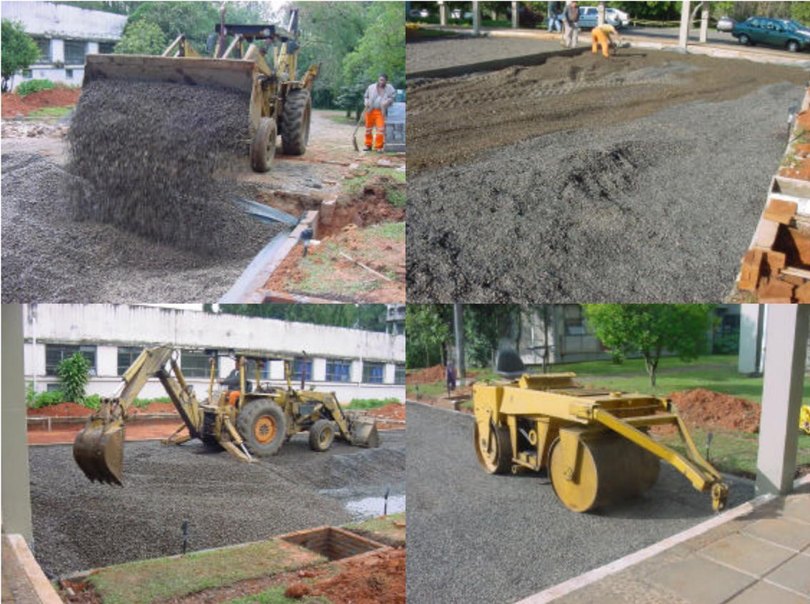
**Figura 3.15** – Execução da base do pavimento permeável
