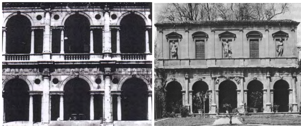
Figura 101 – Vista parcial da fachada da Basilica, onde se observa a irregularidade dos vãos das Serlianas (PUPPI, 1999, p. 76) e vista frontal da Loggia Cornaro, realizada por Alvise Cornaro e Falconetto (com a provável participação de Palladio), onde se observa a distorção do arco central como forma de solucionar a disparidade dos vãos, gerando um efeito pouco clássico de arco abatido.
