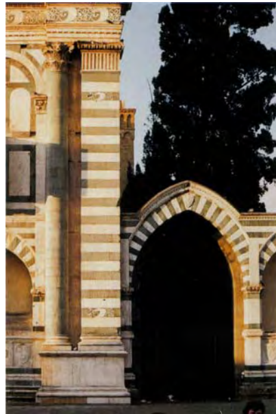
Figura 26 – Detalhe da pilastra-cantoneira e dos arcos ogivais preexistentes em frente ao cemitério, que dão seqüência aos arcos da fachada principal (TAVERNOR, 1998, p. 100).
