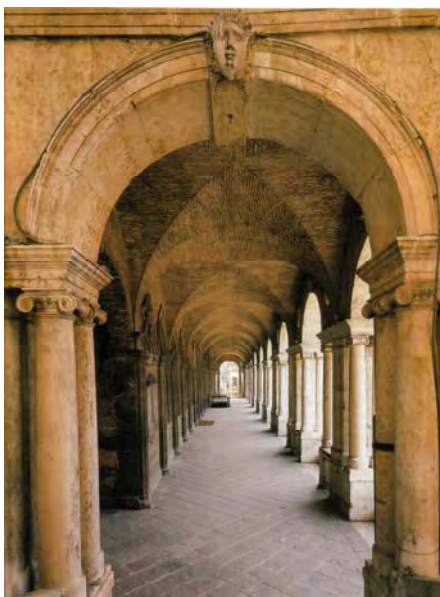
Figura 103 – Vista do interior das arcadas da Basílica Palladiana, cobertas com abóbadas de arestas em tijolo (PAPE; WUNDRAN, 1994, p.73).
