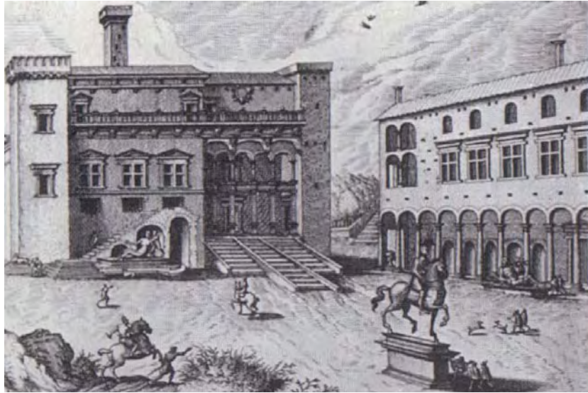
Figura 63 - Vista do Capitólio, executada por H. Cock, retratando o início do revestimento da fachada do Palazzo del Senatore , bem como a execução parcial da escadaria de acesso. Verificamos ainda que o autor acrescentou molduras às janelas dos palácios que não estão presentes no projeto original (ACKERMAN, 1997, p.140).
