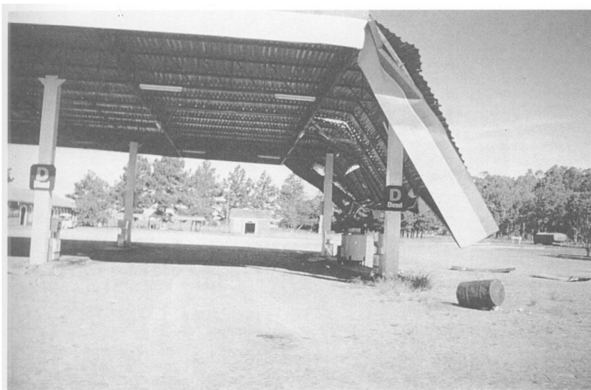
Figura 1: posto de serviço em Santa Maria, RS (BLESSMANN, 2001)
