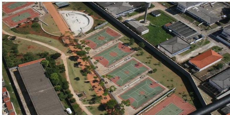
Figura 02 – Vista aérea do Parque Esportivo
