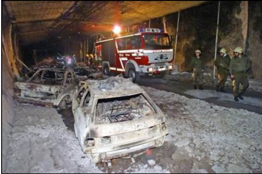
Figura 3: seção do túnel Tauern após o incêndio de 1999 (LRC, 2001).
