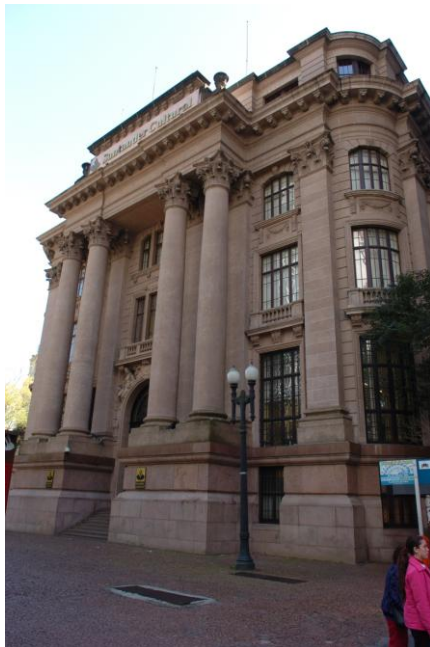
Imagem 1 – Fachada do prédio
