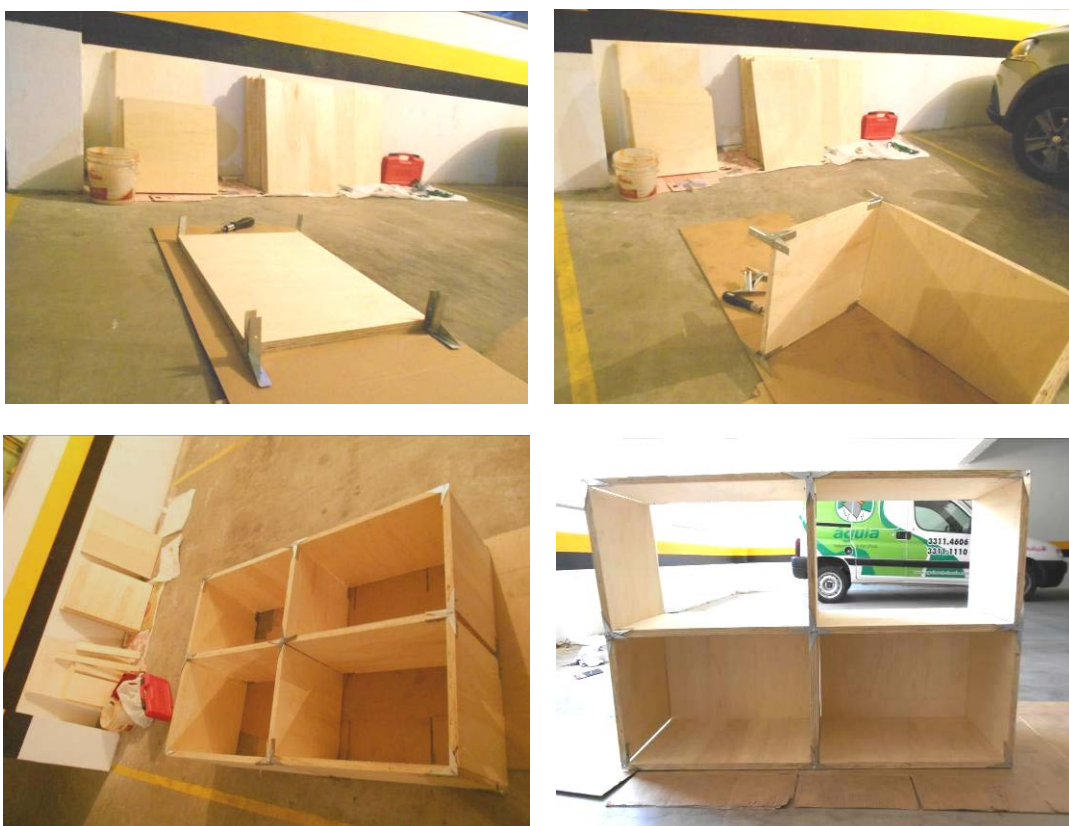
Fig. 49 – Primeiro processo de montagem e estante finalizada. Fonte: Autor.
