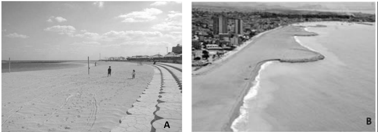
Figura 6. Obras de engordamento artificial de praias no Brasil. A – Típica recuperação de praia por engordamento em Okinawa, Japão (NISHI, 2006). B – Engordamento da praia do Matheus, em Vitória do Espírito Santo.
