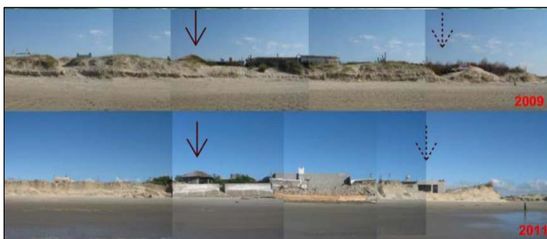
Figura 52: Processo de erosão ocorrido no extremo norte do balneário Hermenegildo entre o período de 2009 e 2011. Fonte: Extraído de Koerner (2012).
